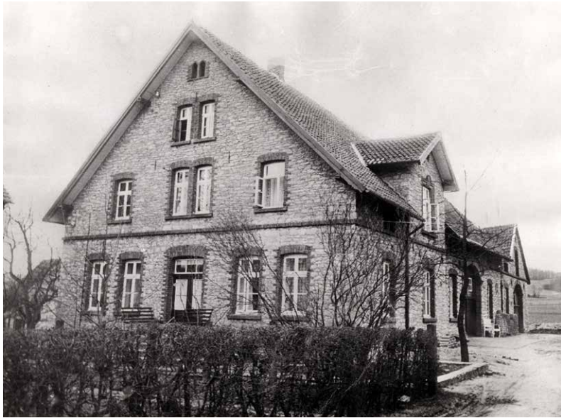
Abb. 4: Ansicht des Hauses der Familie Wesselmann in Borgholzhausen Nr. 52 am Haller Weg. Die Abbildung zeigt das 1890 erbaute und 1976 abgerissene Gebäude. Der Vorgängerbau befand sich auf dem Grundstück am heutigen Vogelgitter (Generationen-Spielplatz). Aus den Resten des alten Hauses wurde am neuen Bauplatz die Scheune angebaut, Foto: Wilhelm Wesselmann.
