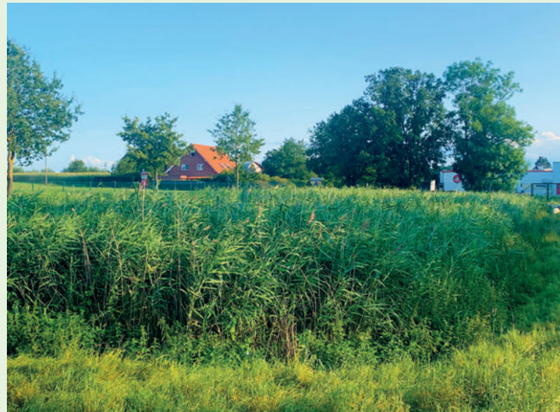
Beispiel für ein schilfbewachsenes drainiertes Rückhaltebecken.
